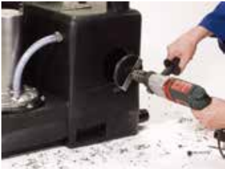
入口连接 Inlet pipe connection
